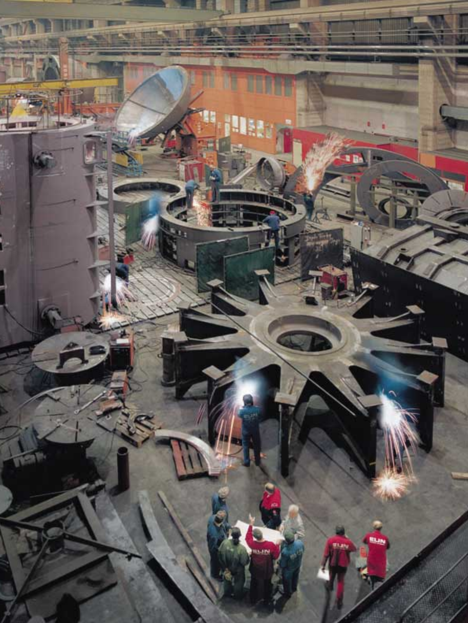
Mitt på golvet ligger en gigantisk rotor till en generator avsedd för elkraftproduktion. Den tillverkas vid ELINs Energieversorgung Ges. m. b. H. division för maskin- och stålkonstruktioner. Företaget som ligger i Weiz i Österrike har nyligen tillverkat världens största rörturbingenerator. De använder AGAs skyddsgaser vid svetsning och har nyligen gått över från propan till acetylen vid värmning och skärning.
